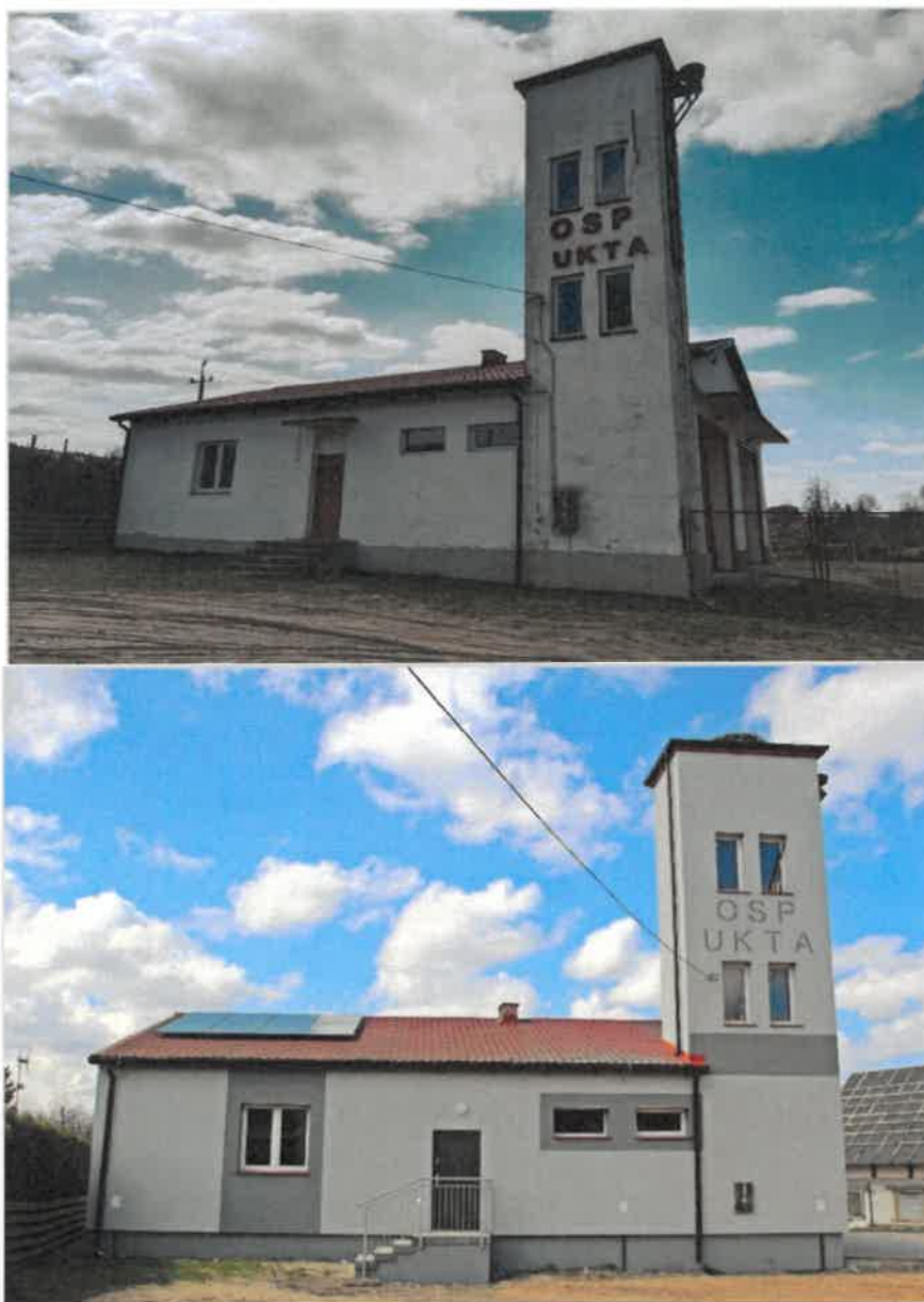
Rysunek 17. Termomodernizacja budynku OSP w Ukcie (źródło: archiwum UMiG, AO)
