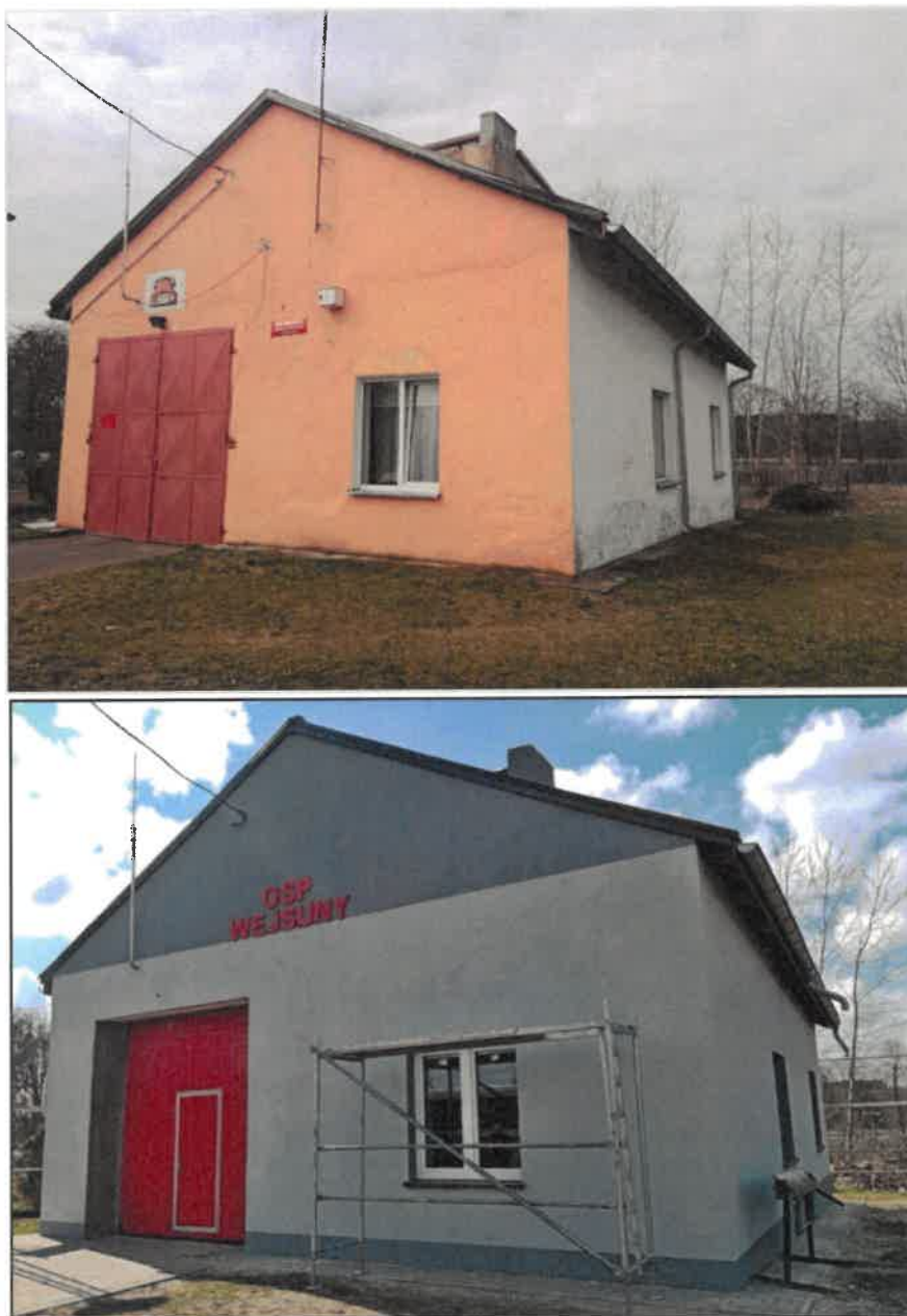
Rysunek 18. Termomodernizacja budynku OSP Wejsuny (źródło: archiwum UMiG, AO)
