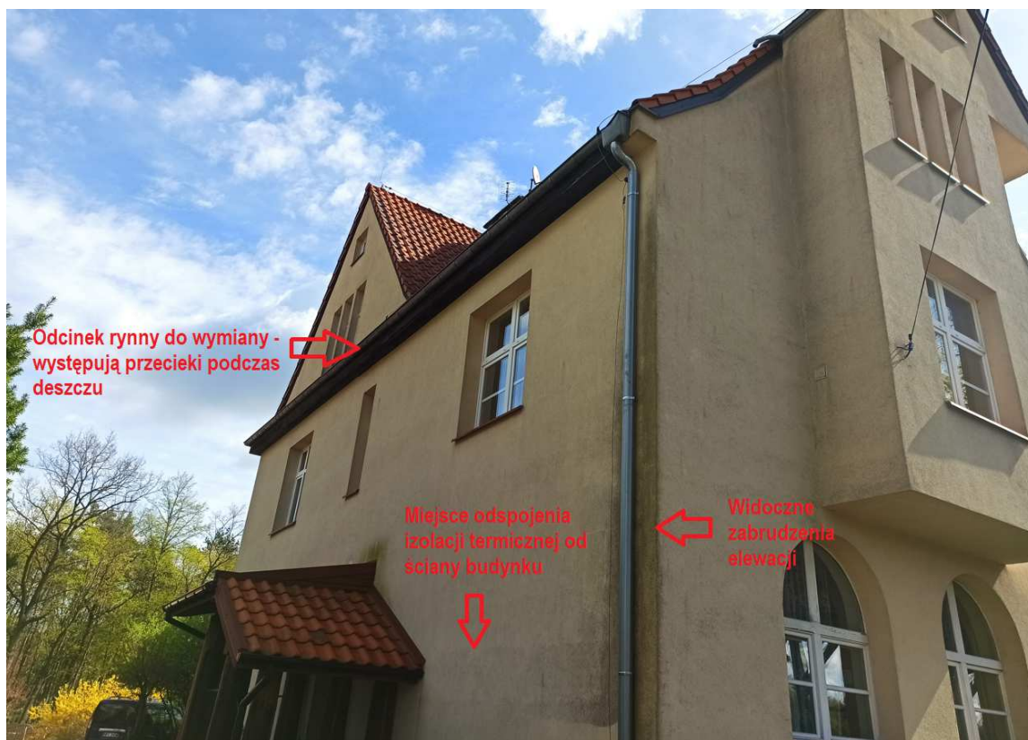
Fotografia nr 4 – Elewacja zachodnia-boczna – podgląd stanu istniejącego z opisem elementów
