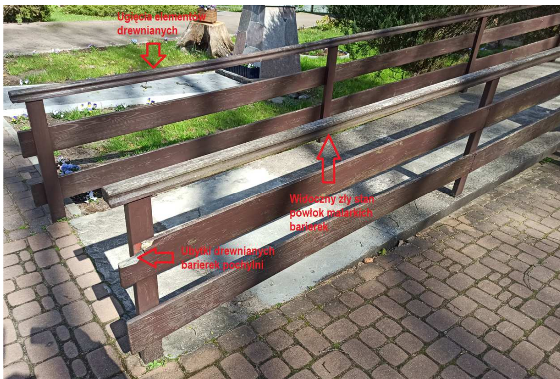
Fotografia nr 6 – Widok części frontowej – podgląd stanu istniejącego pochylni z opisem elementów
