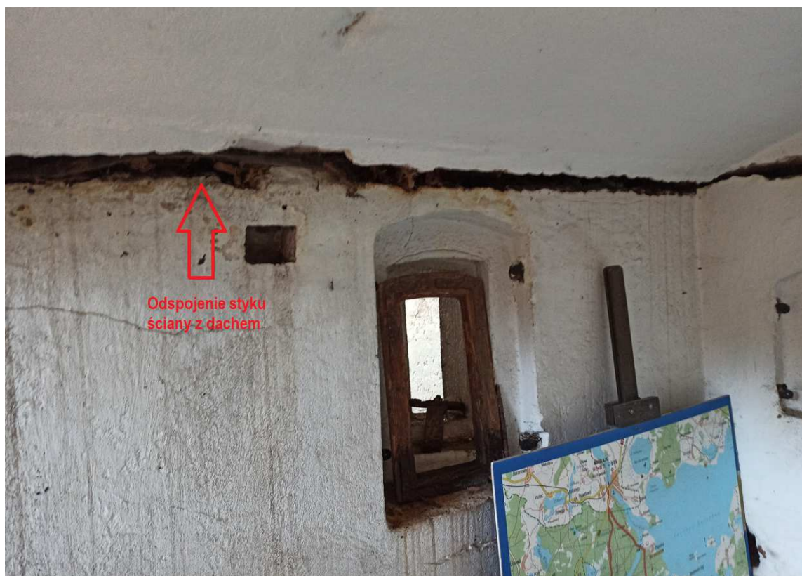
Fotografia nr 6 – Widoczne odspojenie od wewnątrz ściany z dachem
