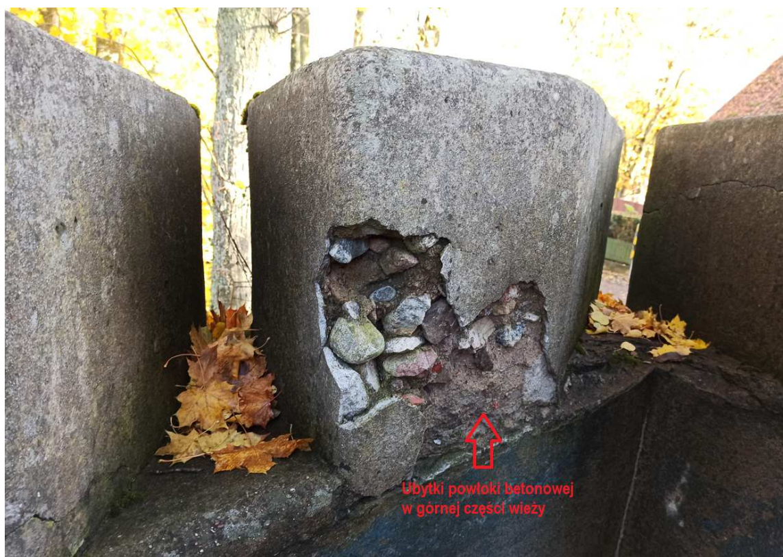
Fotografia nr 7 – Górna korona wieży – ubytek przy stanowisku strzelniczym
