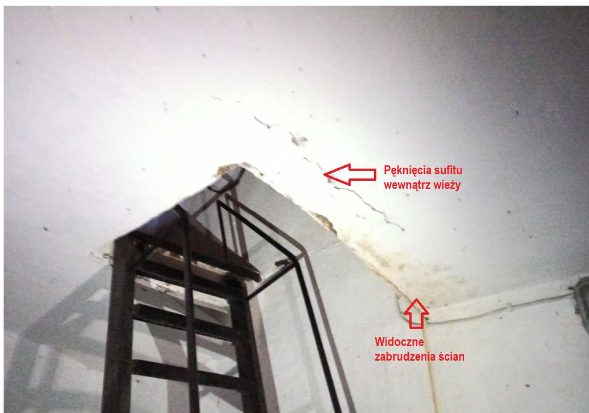
Fotografia nr 13 – Widok wnętrza budynku – podgląd stanu okładzin wewnętrznych
