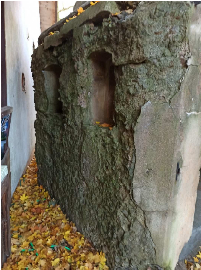
Fotografia nr 4 – Widoczne ubytki powłoki betonowej – fragment przybudówki wieży
