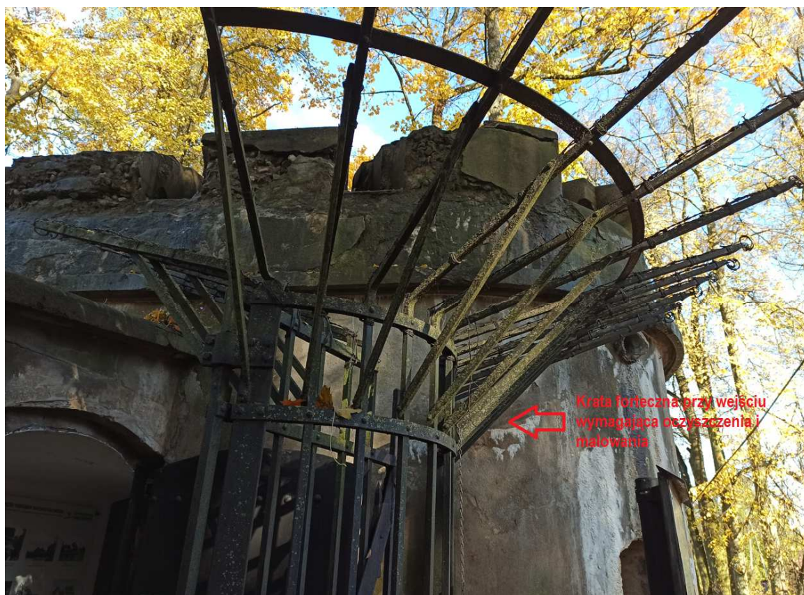
Fotografia nr 10 – Widok na kratę forteczną wymagającą oczyszczenia i malowania
