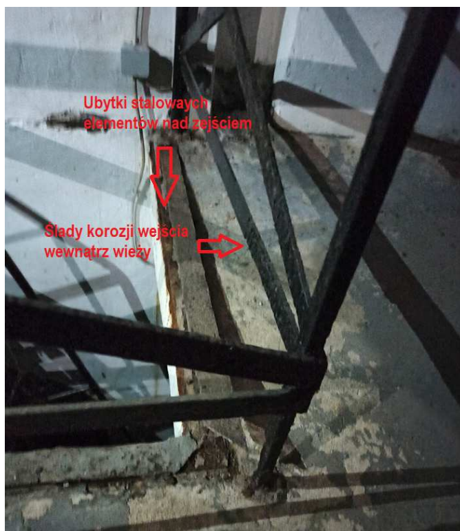
Fotografia nr 14 – Widok wnętrza budynku – podgląd stanu ślusarki wewnętrznej
