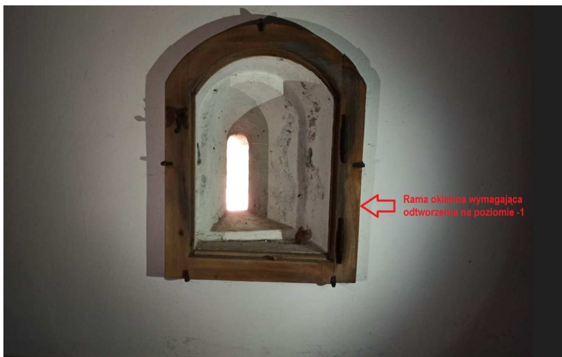
Fotografia nr 11 – Widok wnętrza budynku – rama okienna na poziomie -1 wymagająca odtworzenia
