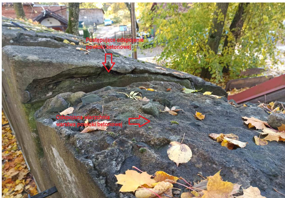
Fotografia nr 8 – Górna korona wieży – ubytki przy stanowiskach strzelniczych
