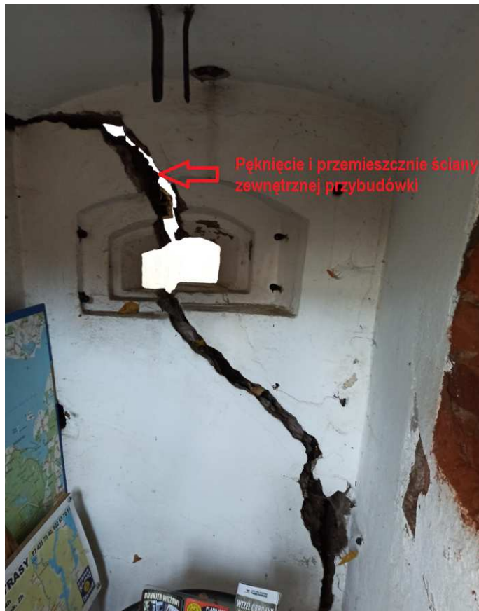
Fotografia nr 5 – Pęknięcie i przemieszczenie ściany przybudówki
