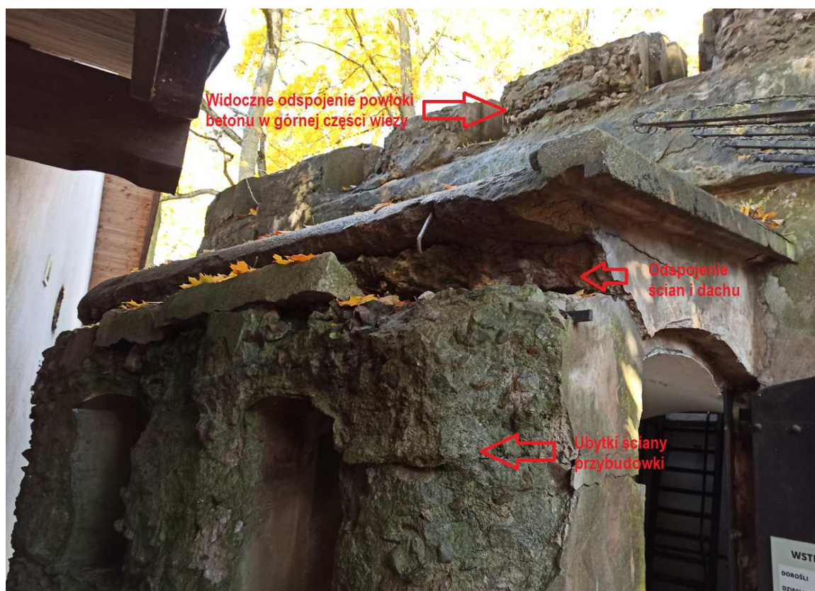
Fotografia nr 3 – Widoczne ubytki i uszkodzenie ścian zewnętrznej powłoki betonowej wieży
