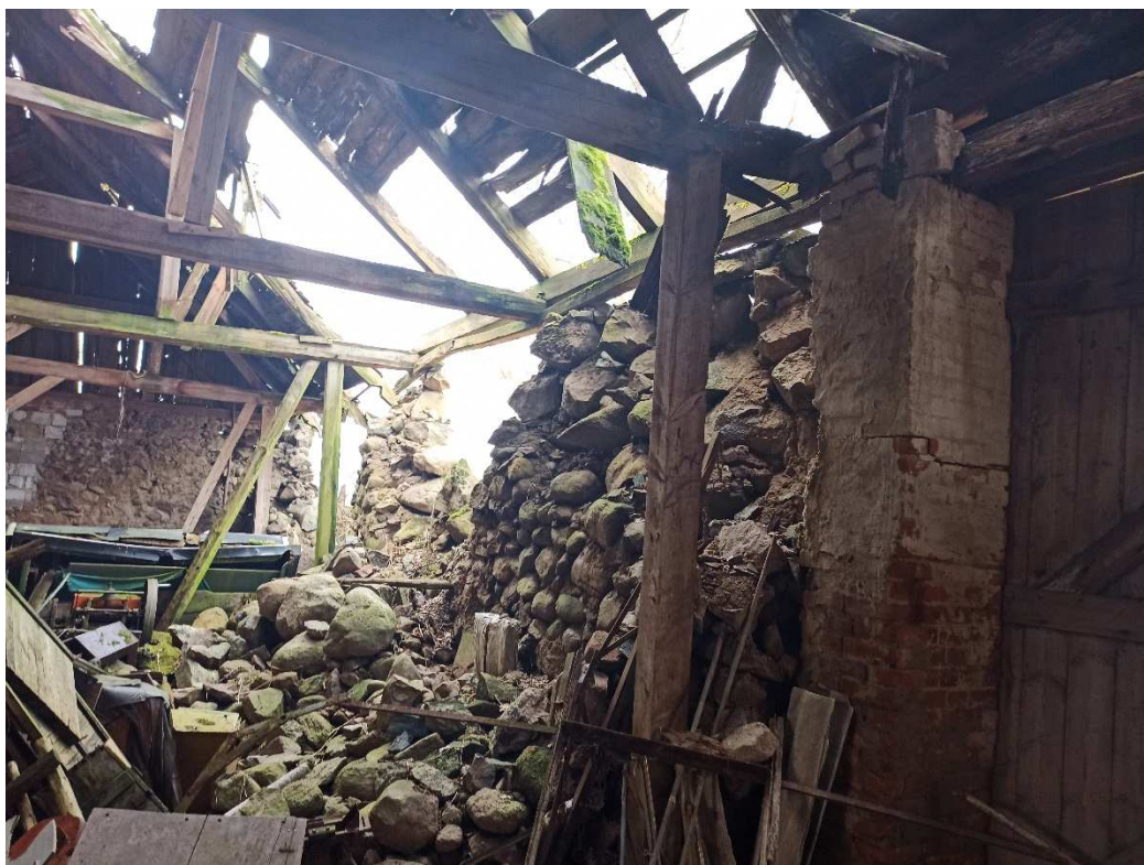
Zdjęcie nr 5 – Widok wnętrza budynku – wewnątrz ściany tylnej – najbardziej zniszczonej
