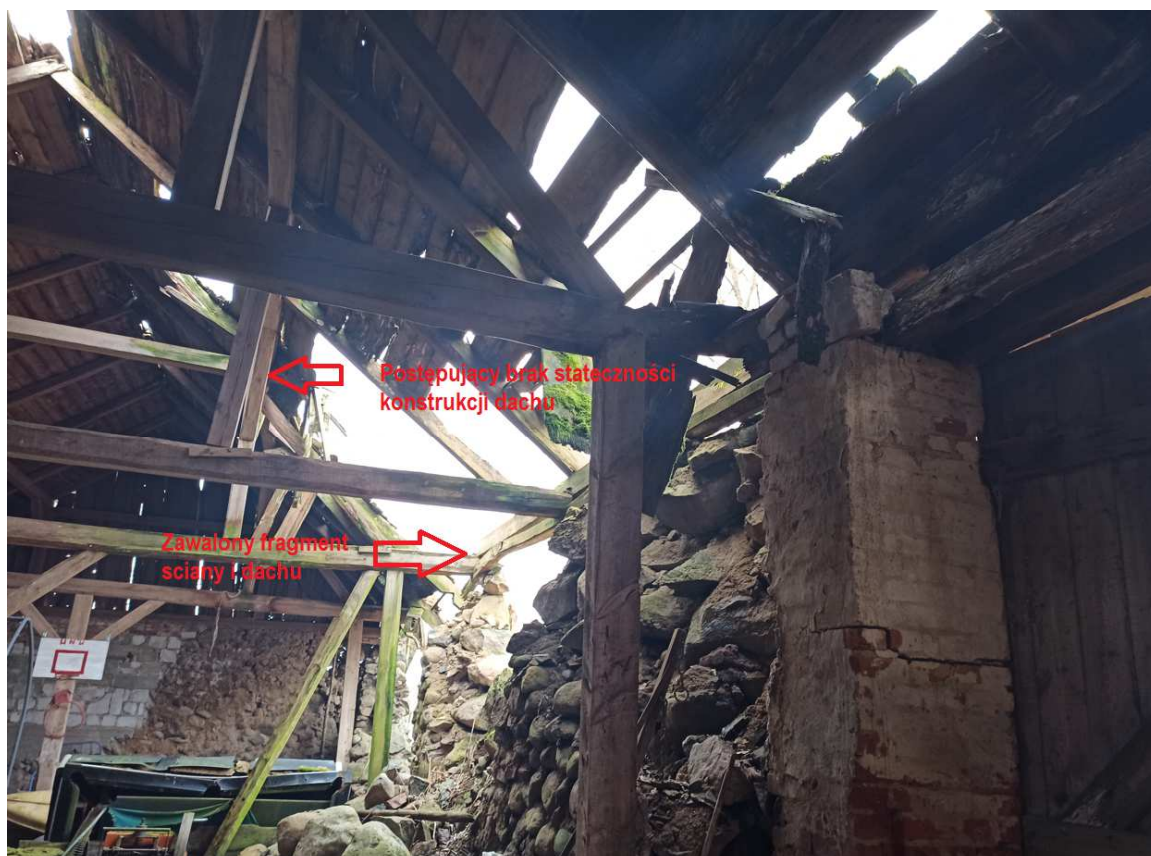
Fotografia nr 9 – Widok wnętrza budynku – podgląd stanu istniejącego z opisem elementów
