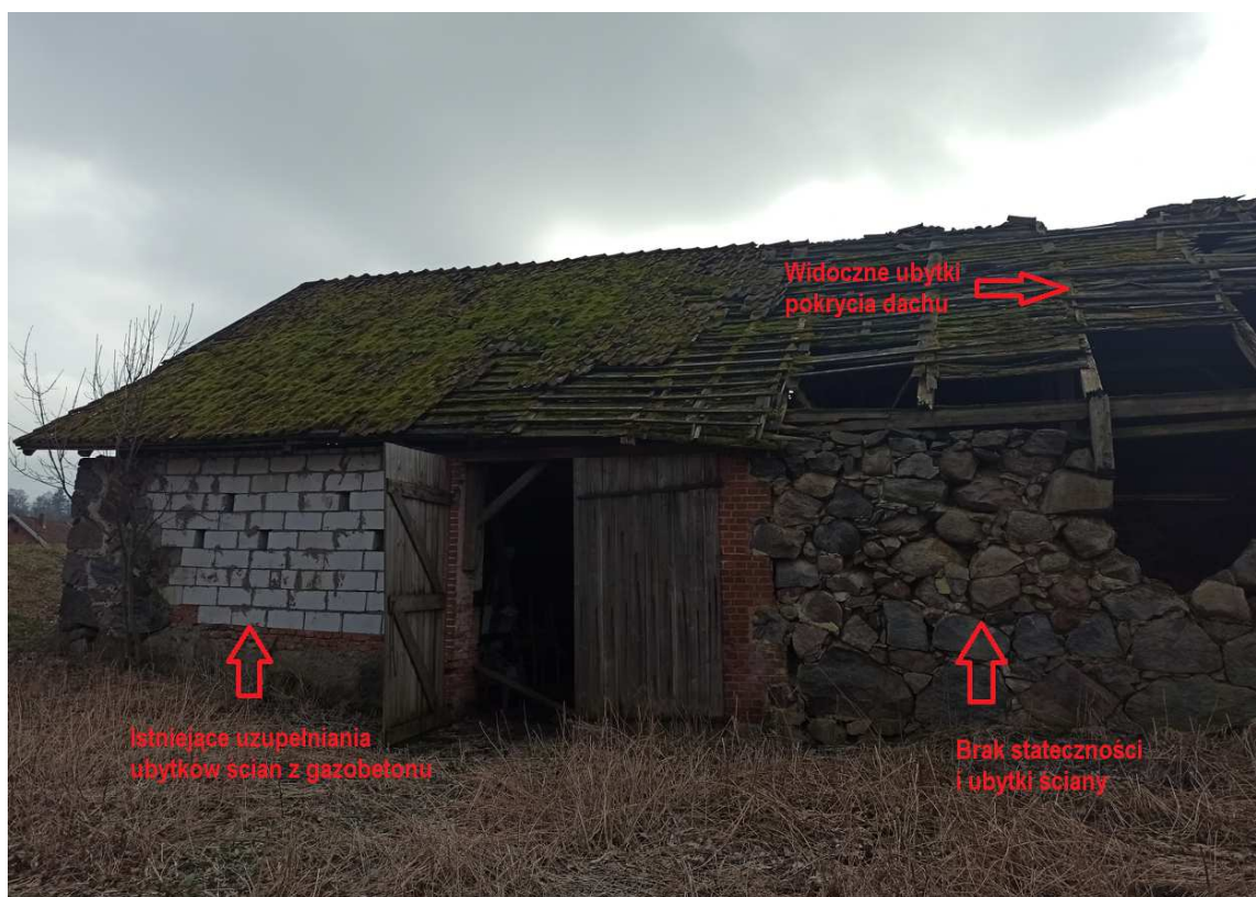
Fotografia nr 6 – Elewacja północna-tylna – podgląd stanu istniejącego z opisem elementów
