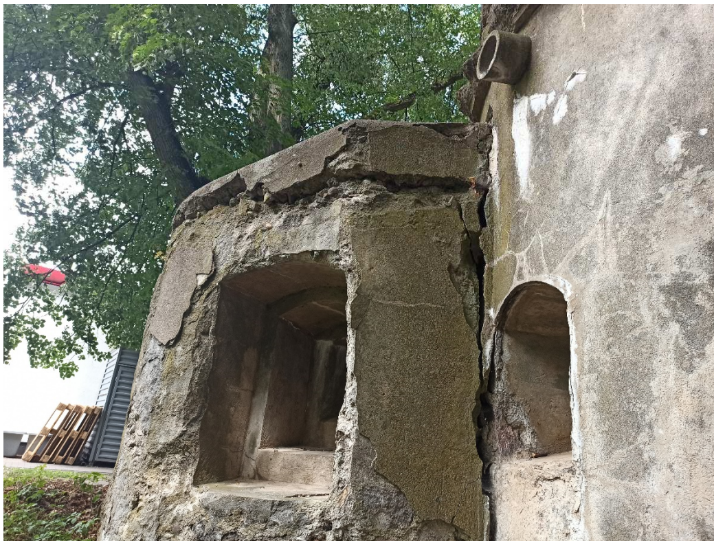
Zdjęcie nr 7 – Wieża nr 1 (ul. Dworcowa) - Widok pęknięć ścian i dachu z zewnątrz przybudówki
