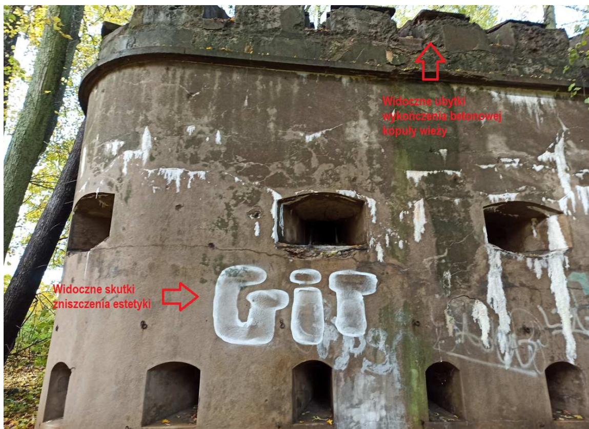
Fotografia nr 5 – Wieża nr 1 - widoczne ubytki i uszkodzenie ścian zewnętrznej powłoki betonowej
