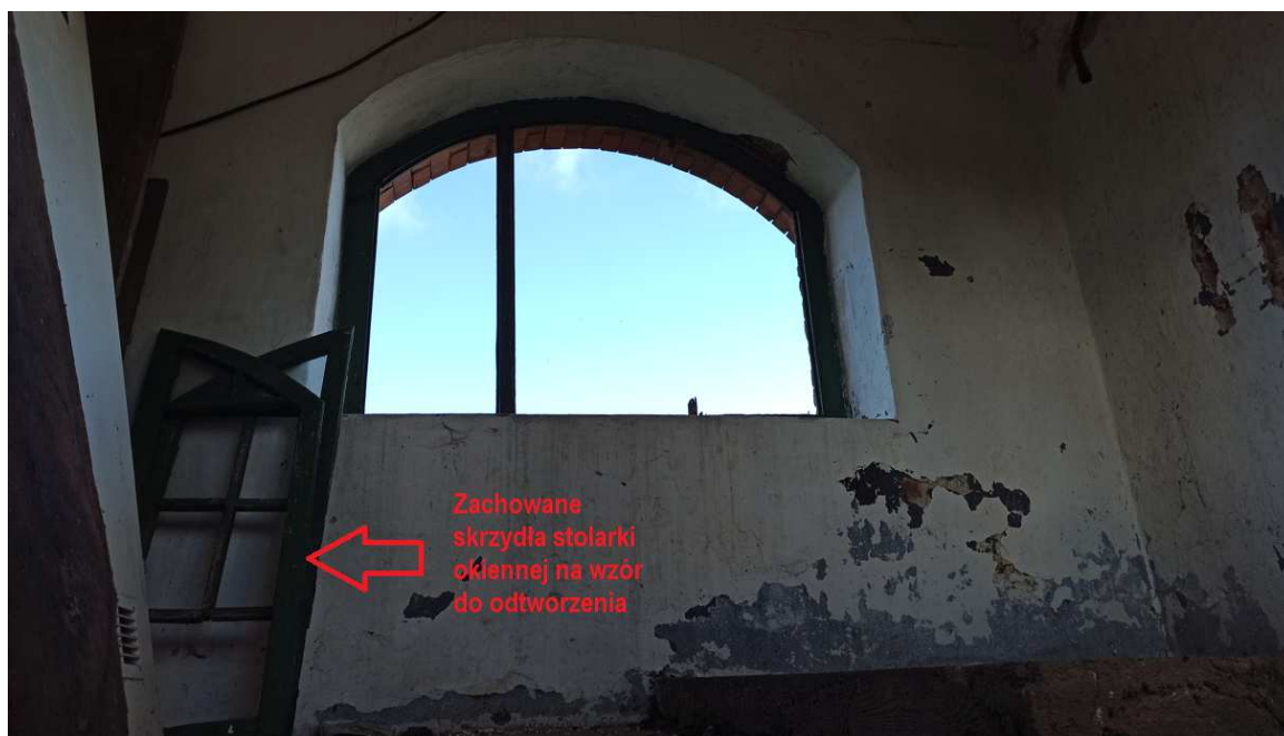
Fotografia nr 11 – Widok na istniejącą zachowaną drewnianą ramę okienną – wewnątrz budynku
