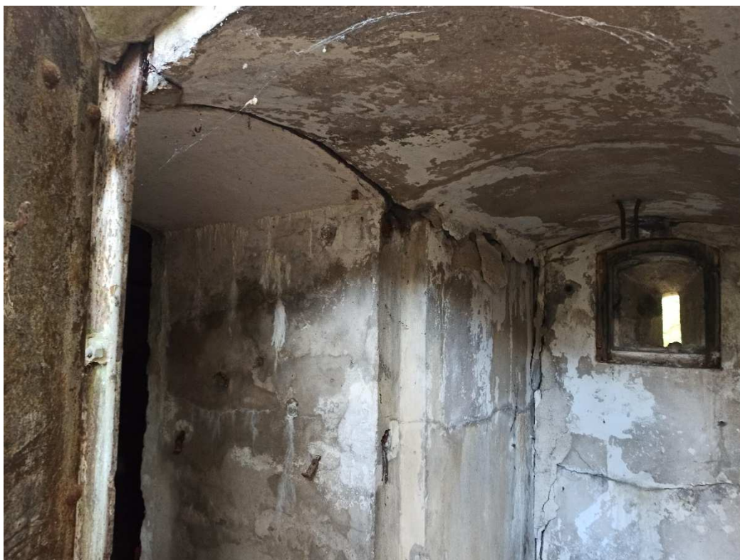
Zdjęcie nr 8 – Wieża nr 1 (ul. Dworcowa) - Widok pęknięć ścian i dachu wewnątrz przybudówki
