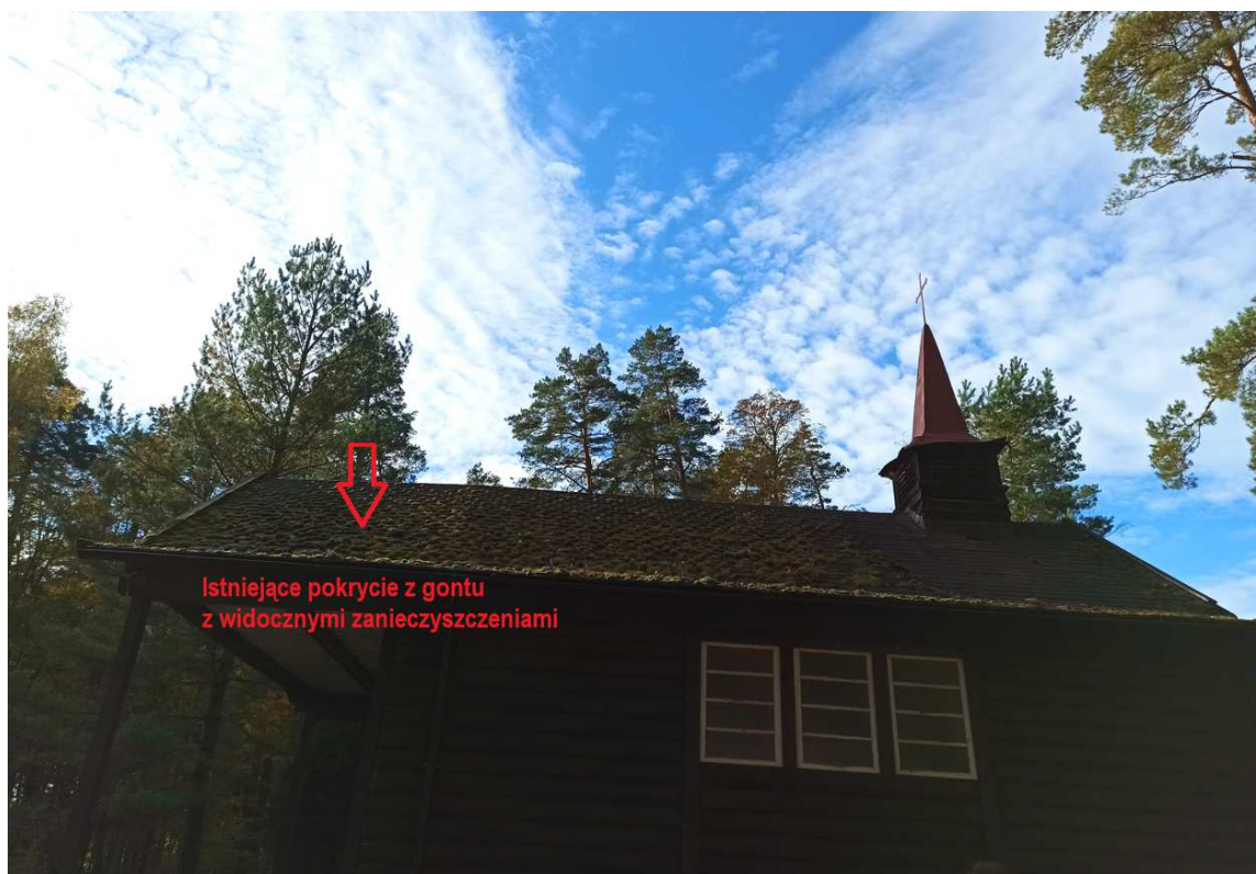
Fotografia nr 6 – Widoczne zużycia pokrycia dachu kaplicy
