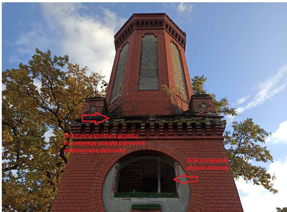
Fotografia nr 6 – Widok wyższej części frontowej – podgląd stanu istniejącego z opisem elementów
