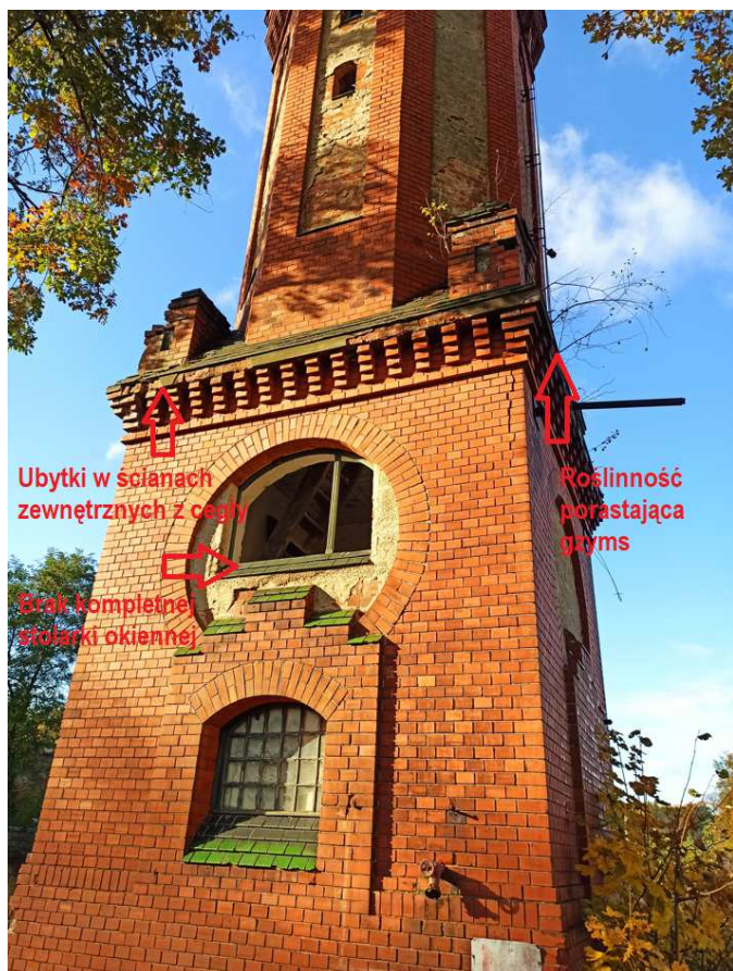
Fotografia nr 4 – Elewacja wschodnia-tylna – podgląd stanu istniejącego z opisem elementów
