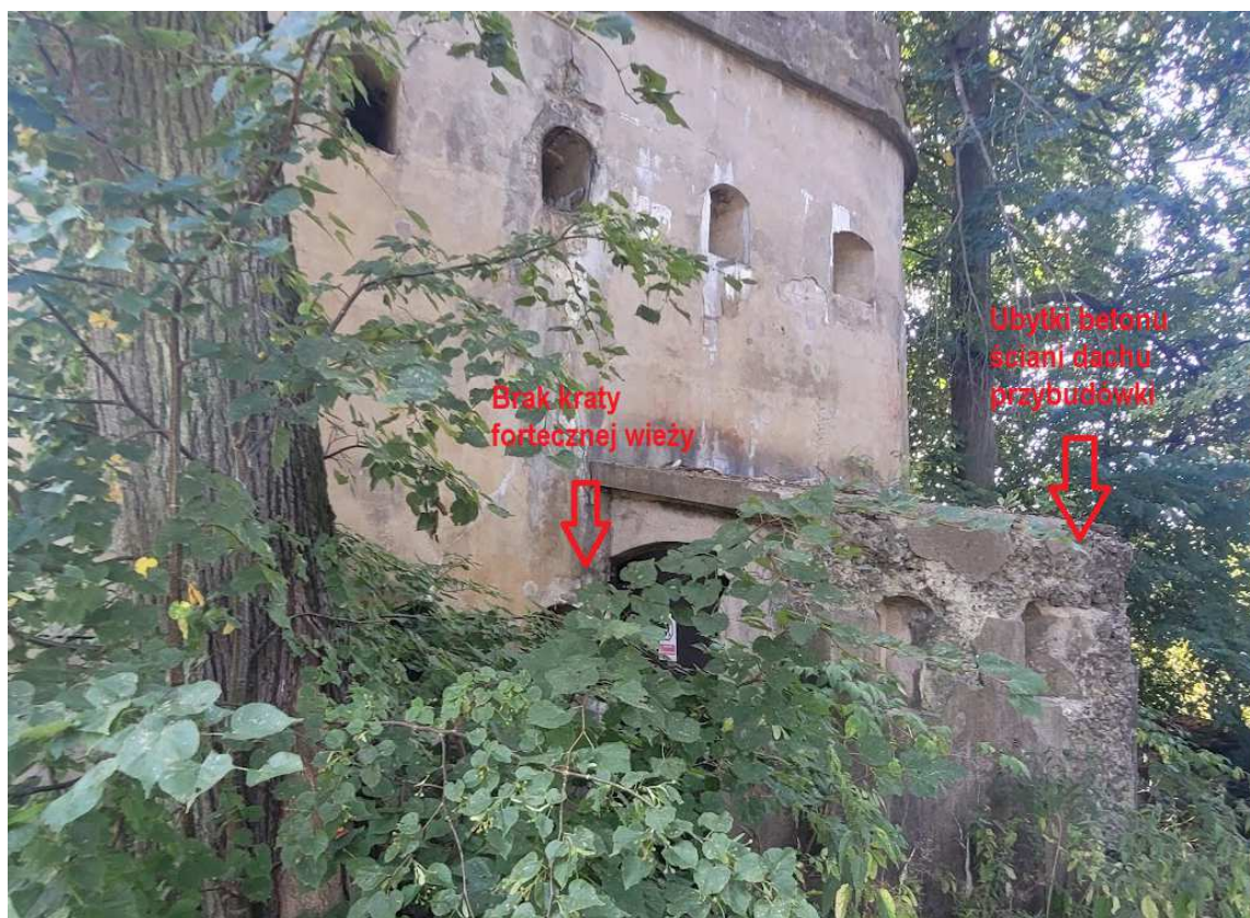
Fotografia nr 10 – Wieża nr 2 – Widoczne ubytki powłoki betonowej oraz brak kraty fortecznej i wrót drzwiowych
