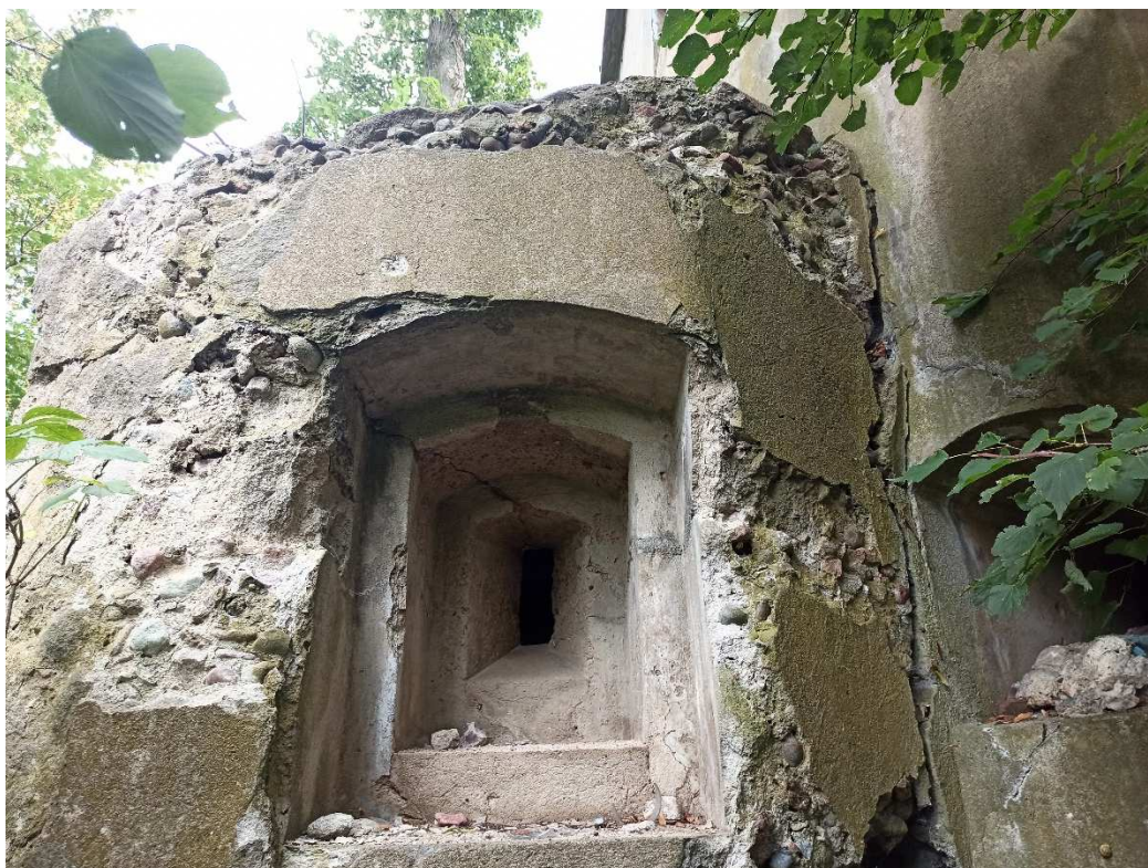
Zdjęcie nr 9 – Wieża nr 2 (ul. Rybacka) - Widok pęknięć ścian i dachu z zewnątrz przybudówki
