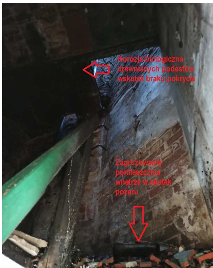
Fotografia nr 7 – Widok wnętrza budynku – podgląd stanu istniejącego z opisem elementów
