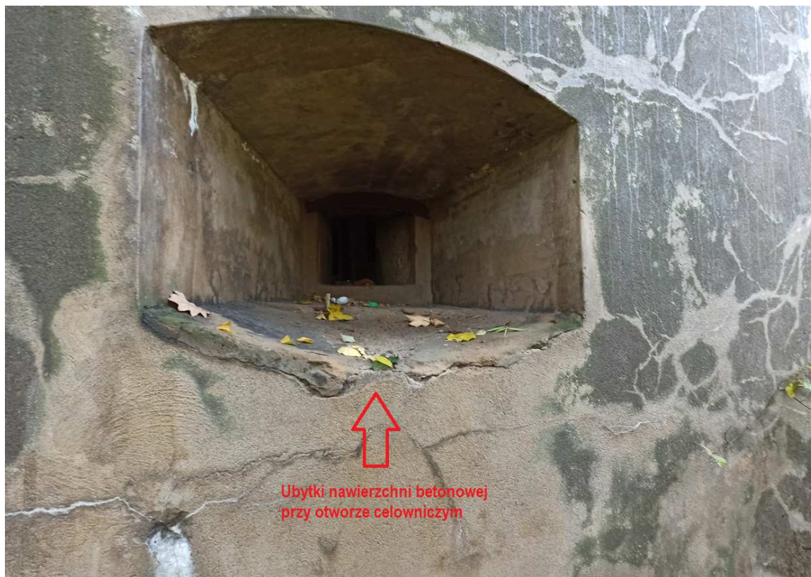
Fotografia nr 4 – Wieża nr 1 - widoczne ubytki i uszkodzenie ścian zewnętrznej powłoki betonowej
