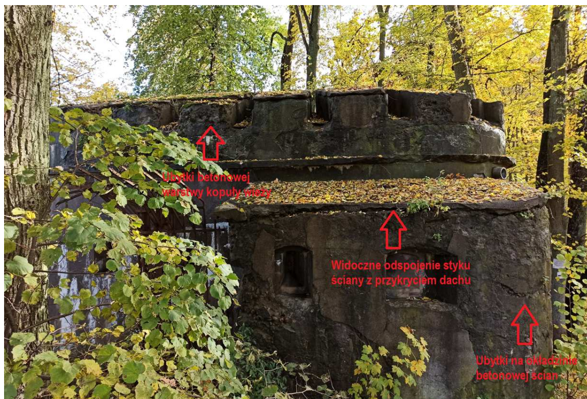
Fotografia nr 3 – Wieża nr 1 – widoczne ubytki i uszkodzenie ścian zewnętrznej powłoki betonowej
