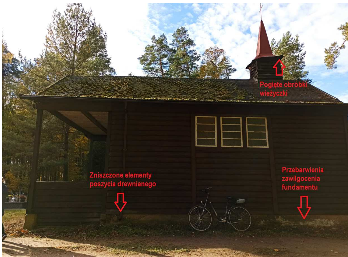
Fotografia nr 7 – Widoczne zniszczenia zewnętrznych elementów ścian i dachu kaplicy
