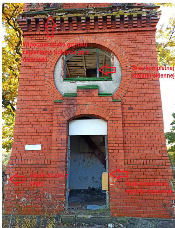
Fotografia nr 3 – Elewacja zachodnia - frontowa – podgląd stanu istniejącego z opisem elementów
