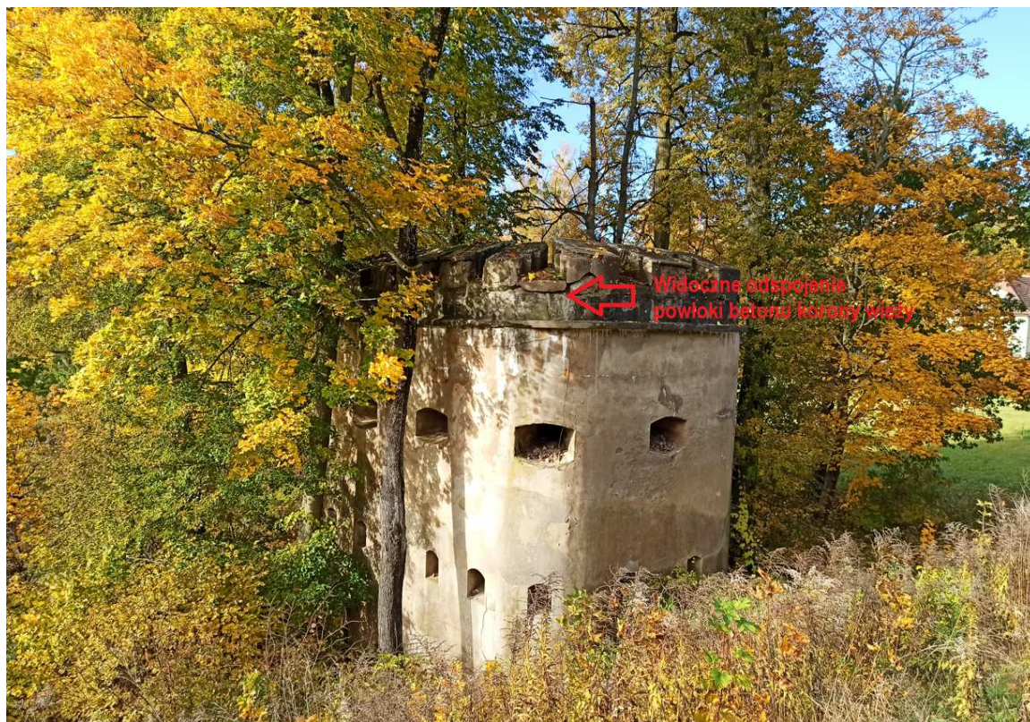
Fotografia nr 8 – Wieża nr 2 - Widoczne ubytki i uszkodzenie ścian zewnętrznej powłoki betonowej
