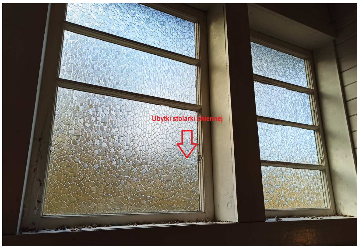
Fotografia nr 8 –Widok z wnętrza kaplicy – ubytki w stolarnie okiennej
