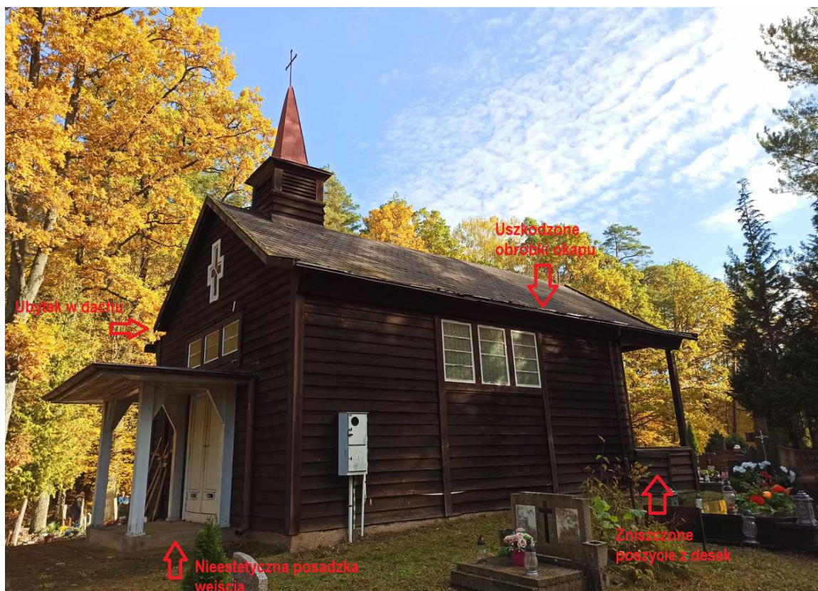
Fotografia nr 4 – Widoczne ubytki zewnętrznych elementów kaplicy cmentarnej
