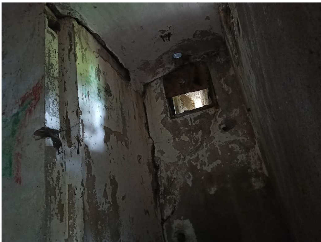
Zdjęcie nr 10 – Wieża nr 2 (ul. Rybacka) - Widok pęknięć ścian i dachu wewnątrz przybudówki
