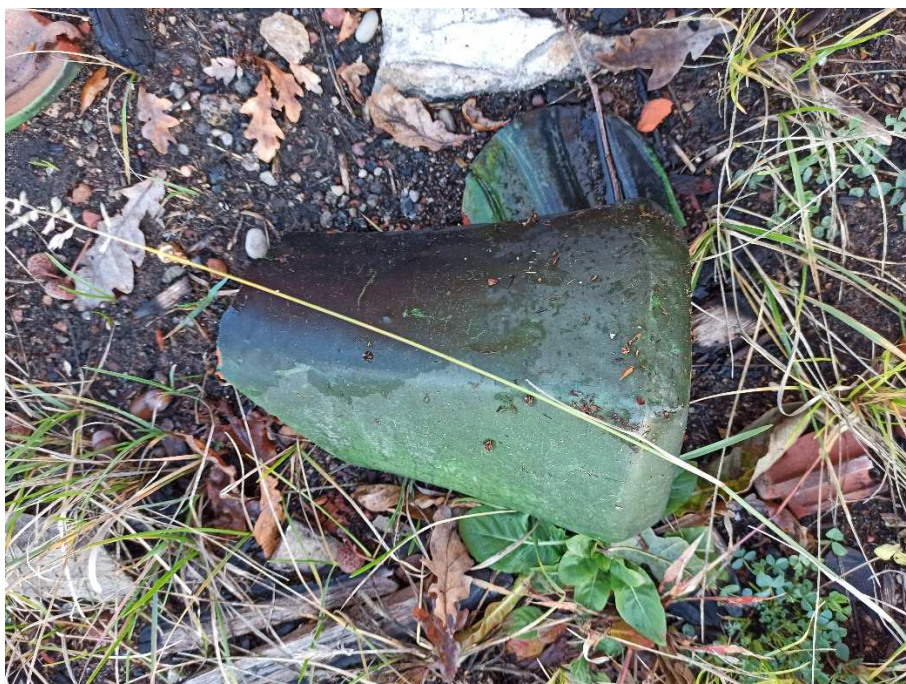
Fotografia nr 10 – Istniejący zachowany fragment pokrycia – gąsior szklwiony na zielono.
