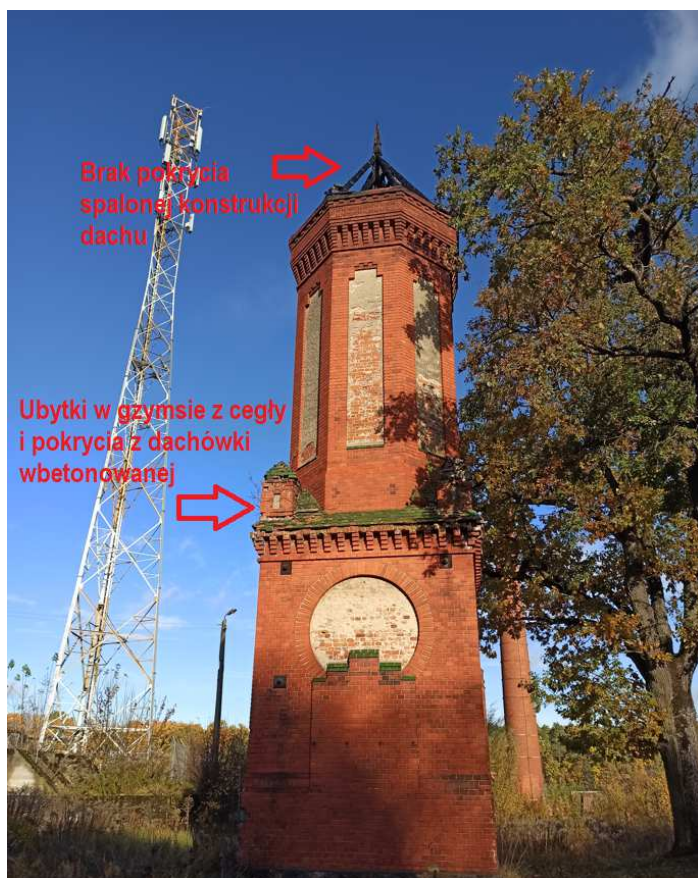
Fotografia nr 5 – Elewacja południowa - boczna – podgląd stanu istniejącego z opisem elementów
