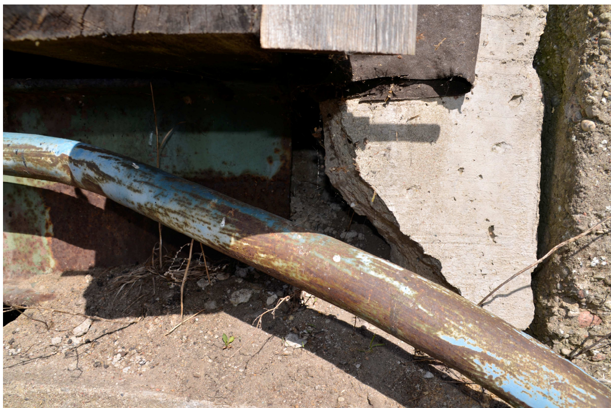
Fot. 4. Odparcie dźwigara na przyczółku – widoczne dźwigary stalowe z resztkami powłoki antykorozyjnej oraz skorodowana rura osłonowa kabla telekomunikacyjnego
