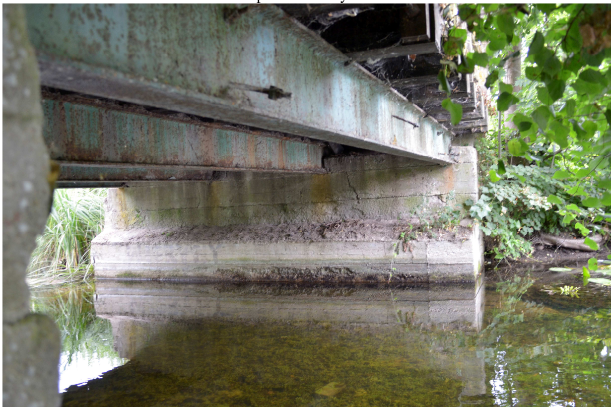
Fot. 3. Widok mostu z boku od strony odpływu. Widoczne skorodowane dźwigary i przyczółki.
