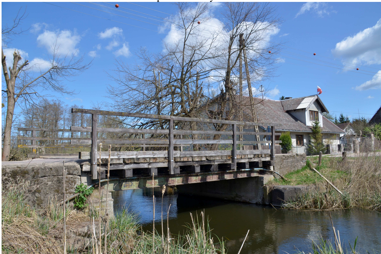
Fot. 1. Widok mostu z boku od strony napływu. Widoczne skorodowane dźwigary i pozostałości urządzeń piętrzących.
