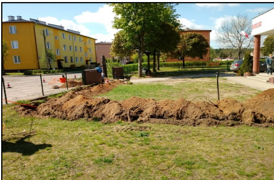
Rysunek 55. Prace polegające na doprowadzeniu światłowodu ( archiwum DK )
